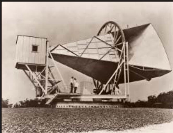
Slika 10. Rog–antena u Holmdelu (New Jersey) kojom su Arno Penzias i Robert Wilson 1965. otkrili slabašno pozadinsko zračenje. Ta čudna mikrovalna antena izvorno je bio namijenjena pokusima za satelitsko prenošenje TV signala preko Atlantika. Snimka: Bell Telephone Laboratories.
